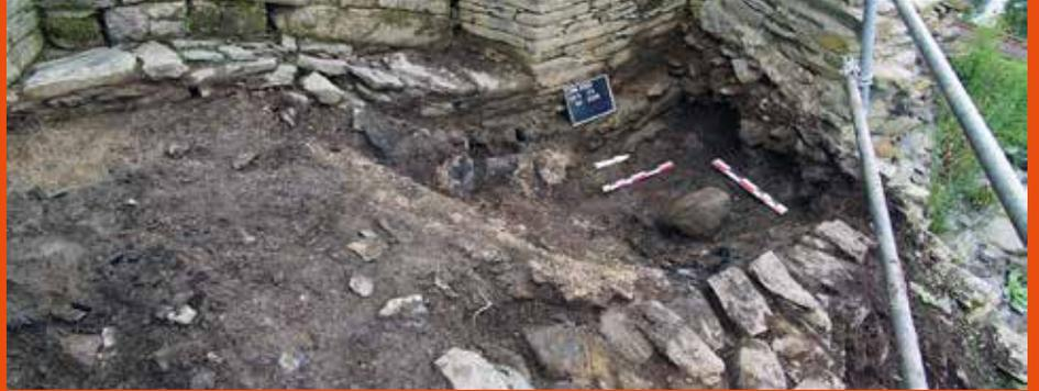
Fig. 1 : Effondrement des sols et du terrain sous-jacent près du rempart nord. L'anomalie de fondation du rempart correspond à une reconstruction du bas Moyen-Age. Cl. R. Pérennec, CD29.
